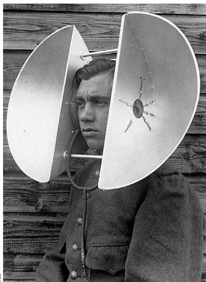
Un bel exemple de prothèse rudimentaire que ce radar acoustique de surveillance aérienne utilisé lors de la Première Guerre mondiale !
